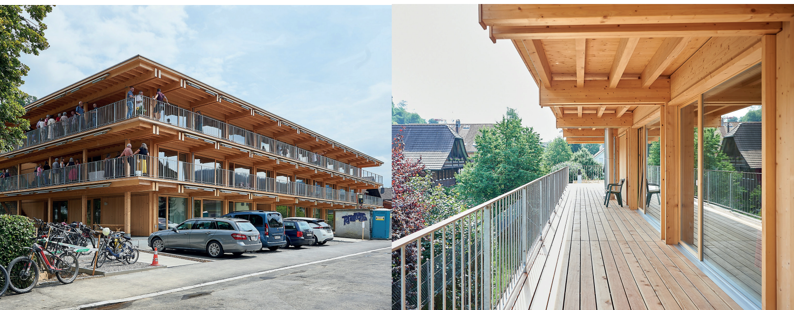
Bâtiment en bois scolyté. Photo: Barbara Héritier
